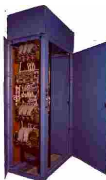
СЕКЦИИ АВТОМАТИЧЕСКОГО ПЕРЕКЛЮЧЕНИЯ АВАРИЙНОГО ОСВЕЩЕНИЯ
